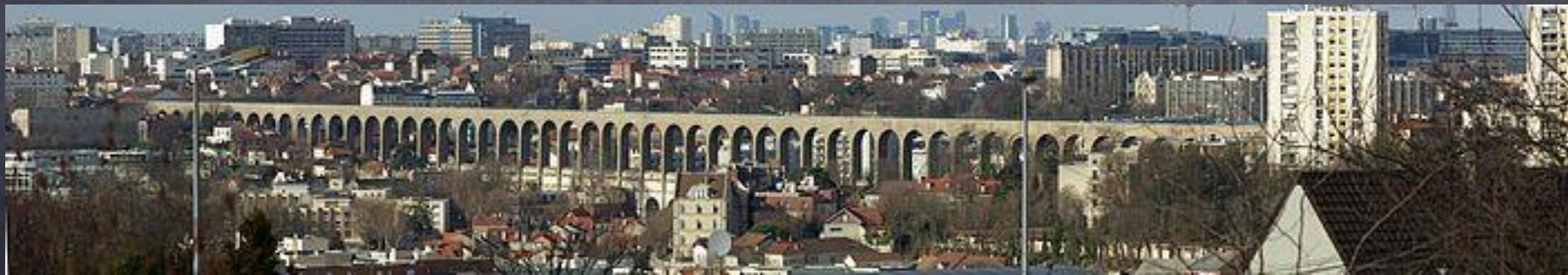
Aqueduc Médicis (aqueduc des eaux de Rungis) (1623....)
